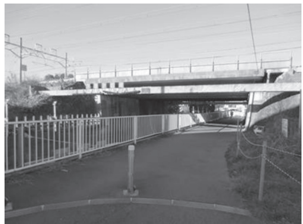
画像 5 ガード東側の歩道入口（南側から撮影）
