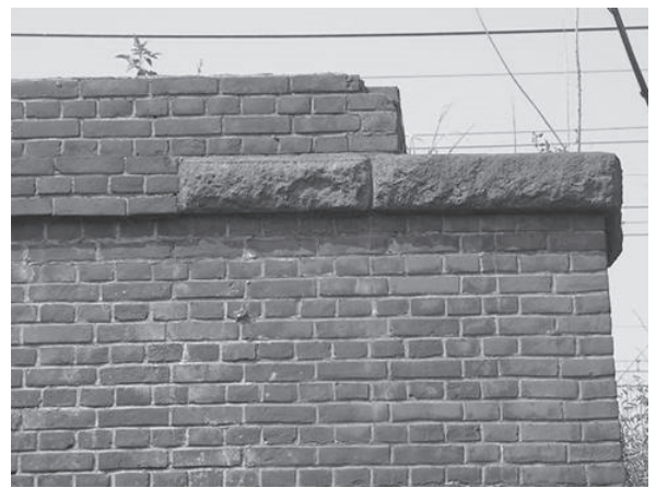
画像 15 橋台上部（旧下り線西側南面）
