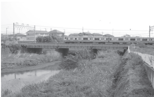
画像 8 茅ヶ崎川橋梁 (北側の中島橋から撮影) 撮影：田中節夫氏
