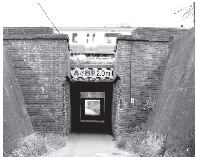
画像 18 旧中島川橋梁下り線橋台 （東海道本線上り線が走行中）
