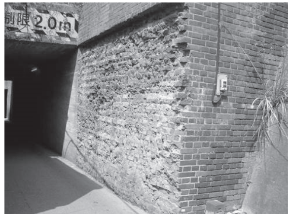
画像 16 橋台下部レンガ組積の欠き取り状況 （旧下り線東側正面・側面）
