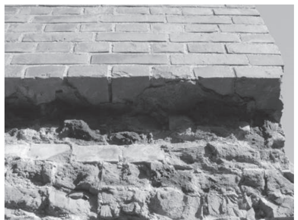
画像 17 レンガ組積の様子 （旧下り線東側正面上部）
