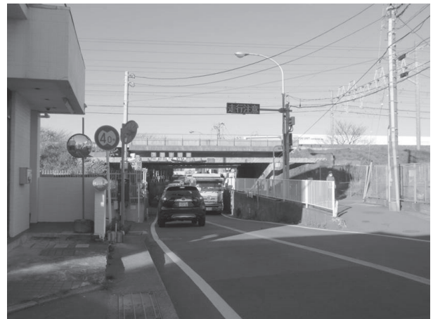
画像 3 鳥井戸架道橋 （南側から撮影、高さ制限 4.0m）
