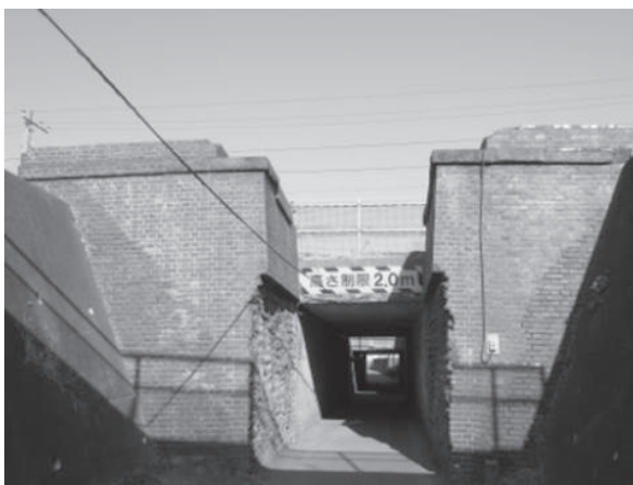
画像 14 橋台構造物全景（旧下り線側南面）
